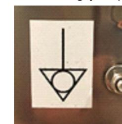
Utilizado para garantir que não haja diferença de potencial entre os diferentes equipamentos ligados a rede elétrica, diminui significativamente os riscos de choques elétricos;
