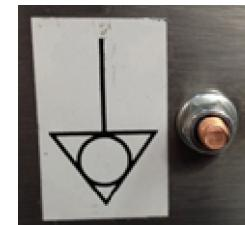
Utilizado para garantir que não haja diferença de potencial entre os diferentes equipamentos ligados a rede elétrica, diminui significativamente os riscos de choques elétricos; Cada equipamento elétrico deve ser ligado um ao outro pelos seus respectivos terminais de ligação equipotencial;
