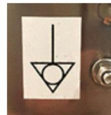
Utilizado para garantir que não haja diferença de potencial entre os diferentes equipamentos ligados a rede elétrica, diminui significativamente os riscos de choques elétricos;
